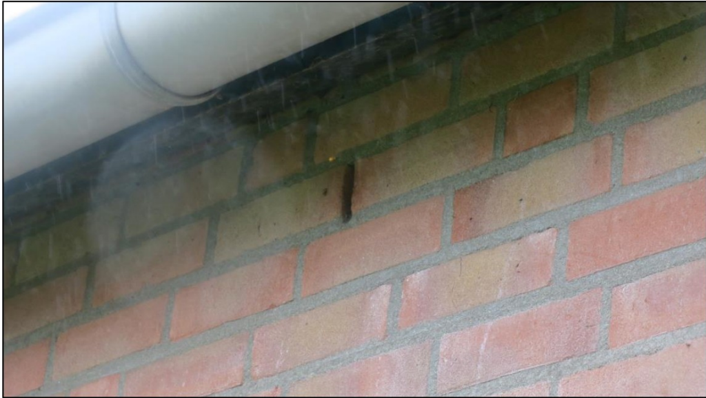
Figuur 3 In een van de stootvoegen is een wespennest aanwezig. Dit kan betekenen dat er genoeg ruimte kan zijn voor vleermuizen in de spouwmuur.
