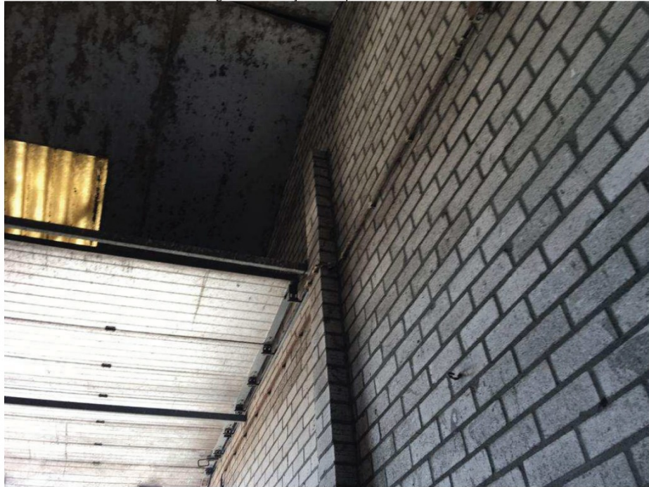
• Afbeelding 11: binnenzijde te slopen schuur
