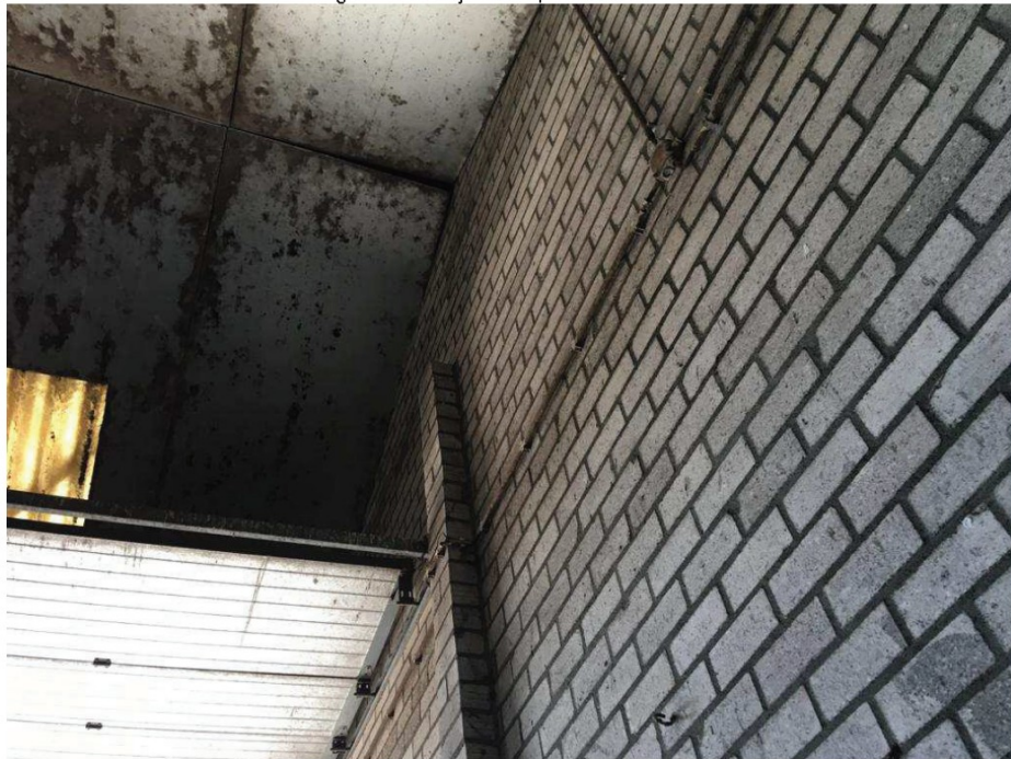
• Afbeelding 12: binnenzijde te slopen schuur
