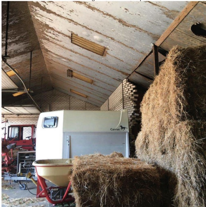
• Afbeelding 30: aanzicht te slopen schuur
