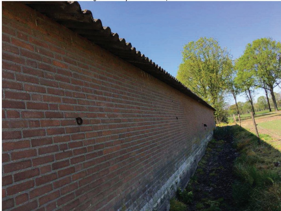
• Afbeelding 14: buitenzijde en dak te slopen schuur
