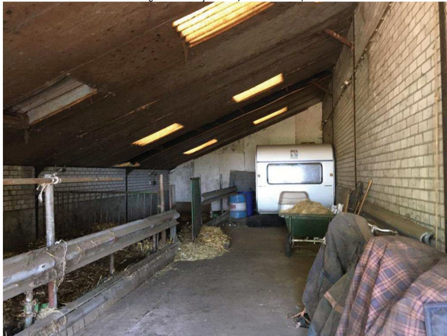
• Afbeelding 16: binnenzijde te slopen schuur met paardenstallen
