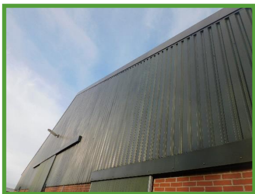
overzicht van de te slopen schuur
