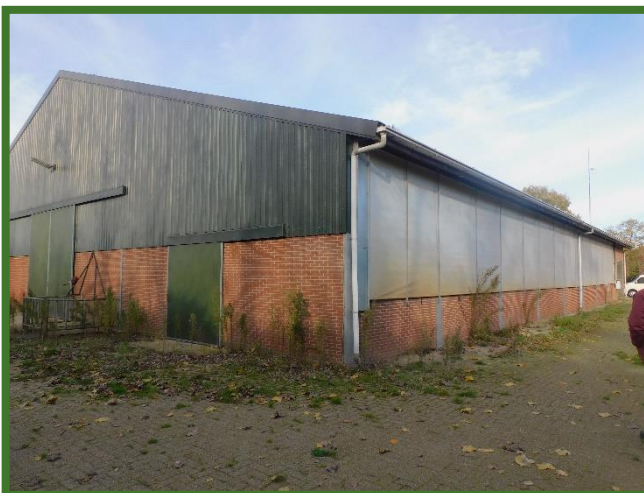
de te slopen loods
