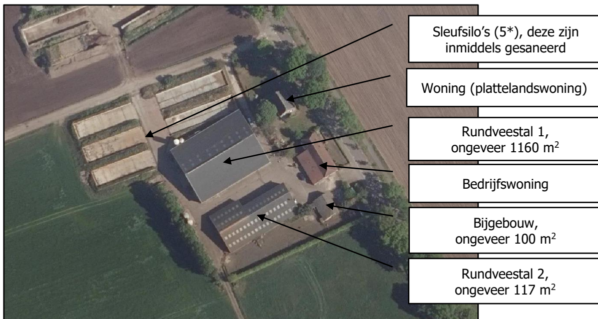
Afbeelding 5: weergave bestaande situatie projectlocatie
