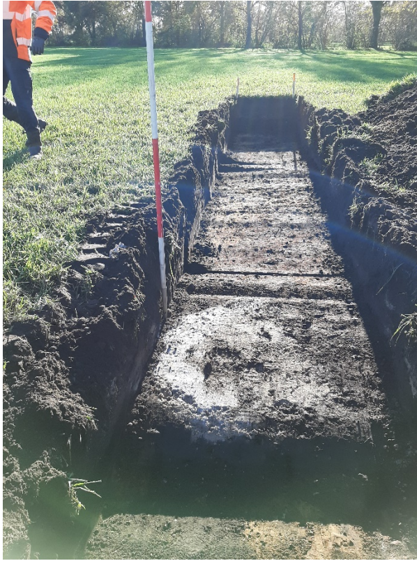
0,4 m-mv met beton (voor jalon)
