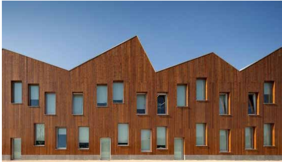
Referentie deelgebied 2: Kappenlandschap en houten gevelbekleding
