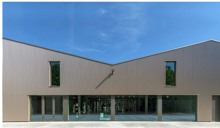
Referentie deelgebied 2: Gevelopeningen
