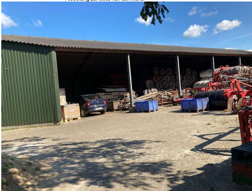
• Afbeelding 23: loods van damwand
