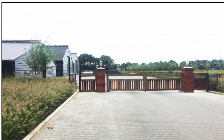
Afbeelding 42: poort waar achter parkeervoorzieningen zijn aan de Duifhuizerweg 29 Bron: K. Weren.
