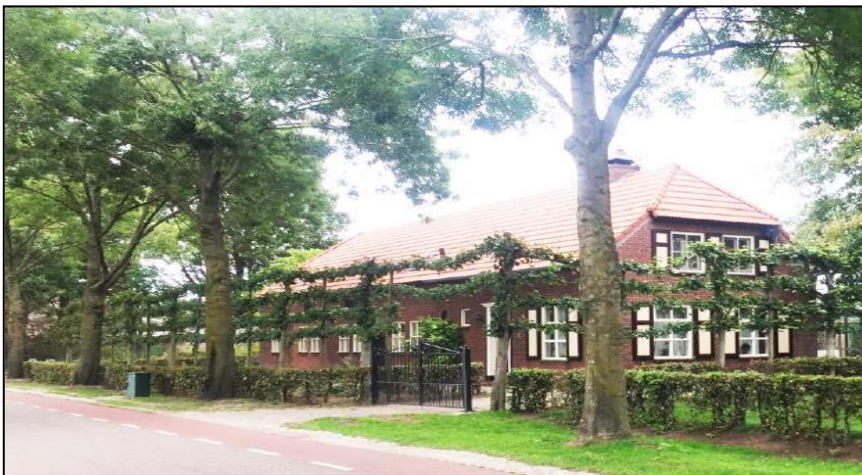
Afbeelding 16 Bedrijfswoning; gerenoveerd (bron: Q-X Design).
