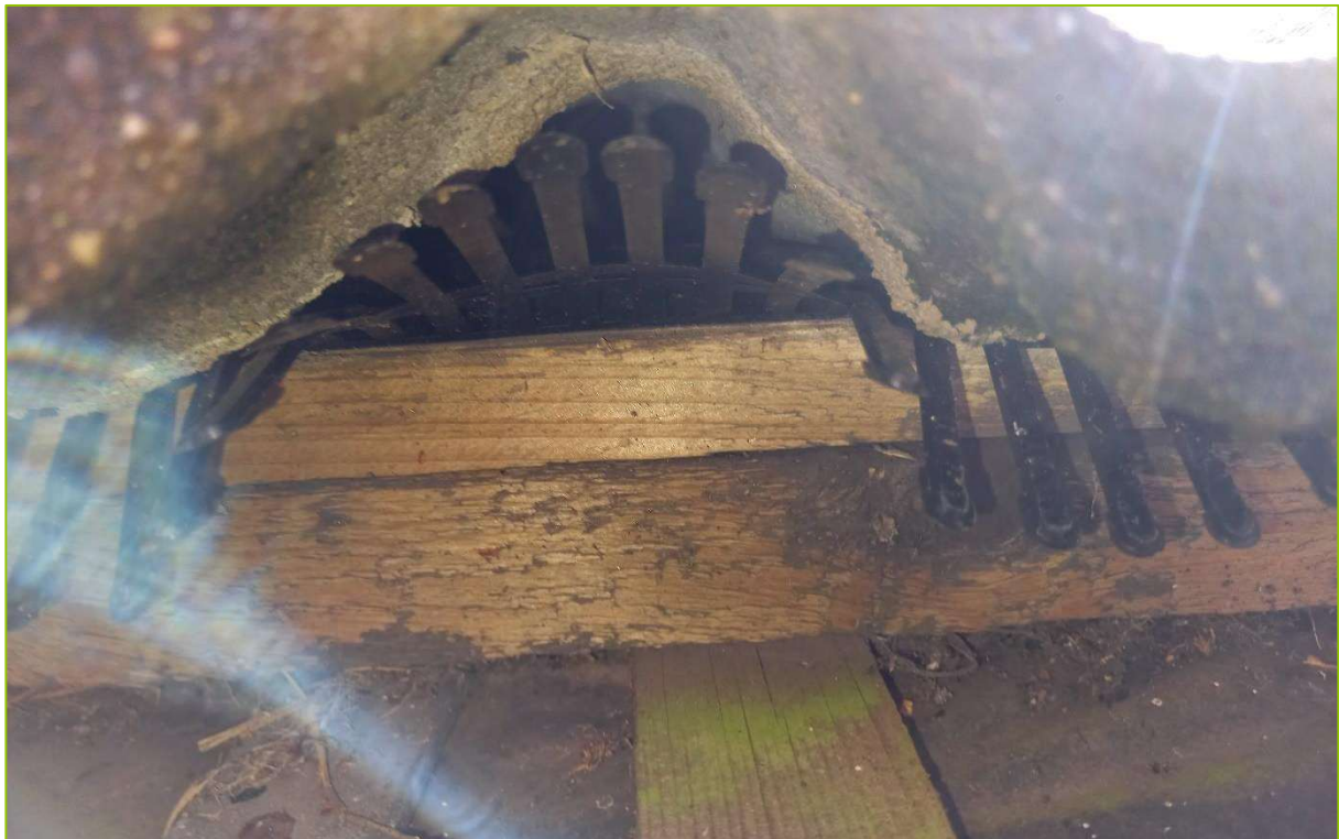
Figuur 3 De onderste laag dakpannen is afgewerkt met vogelschroot
