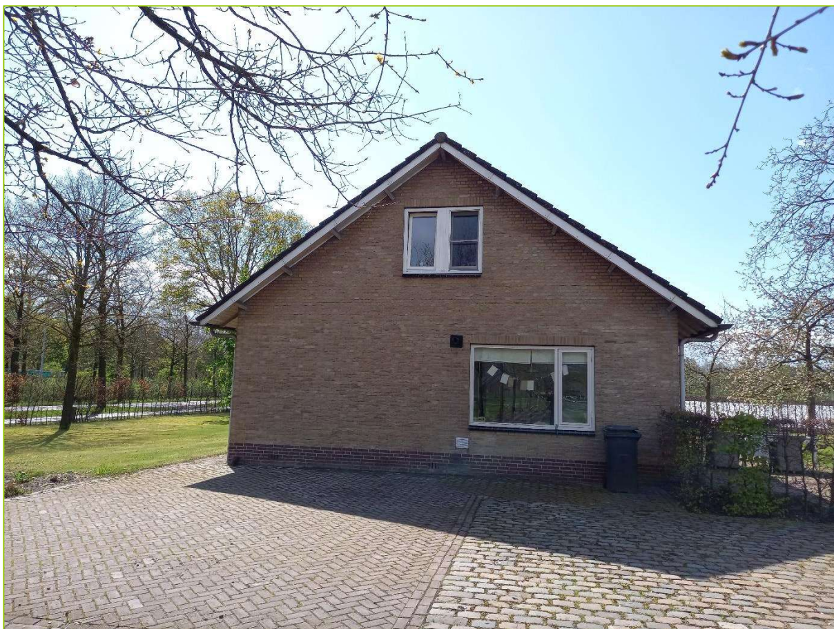
Het te saneren gebouw heeft een pannendak met nauw aansluitende pannen en een houten overstek.
