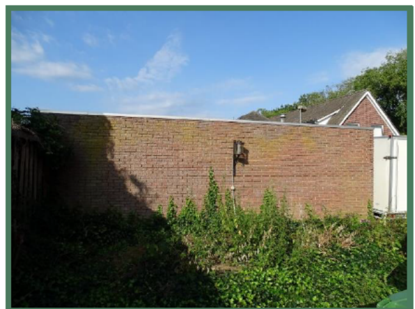
Dichte wand garage
