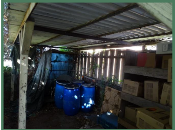
Overzicht binnenzijde bijgebouwtje
