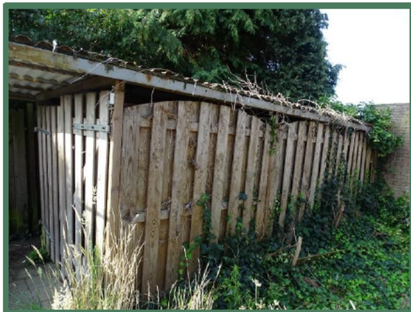
Overzicht buitenzijde bijgebouwtje
