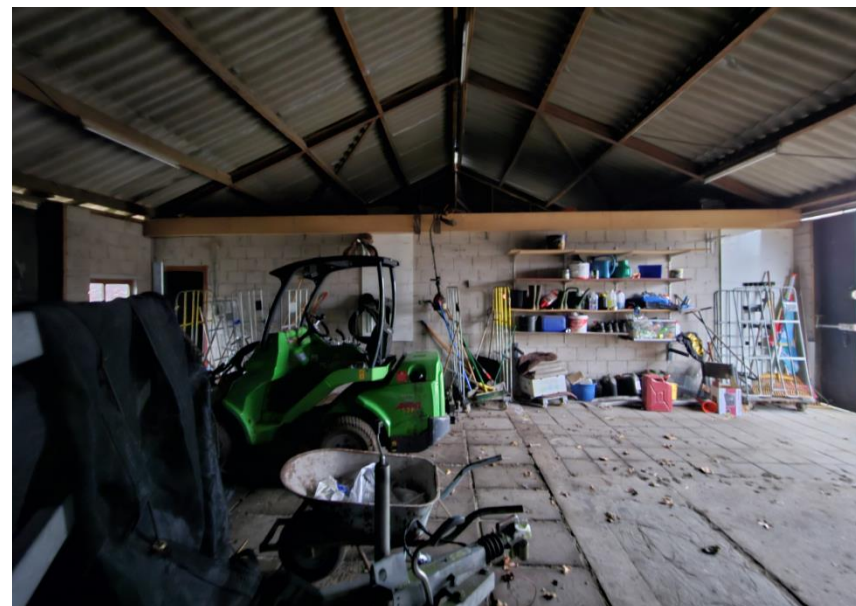
Figuur 8: Binnenzijde voornemens te slopen schuur
