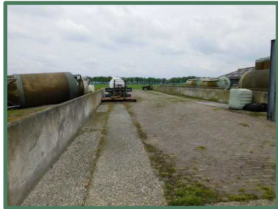
Overzicht te verwijderen sleufsilo
