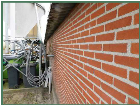
Overzicht wand zonder scheuren of kieren
