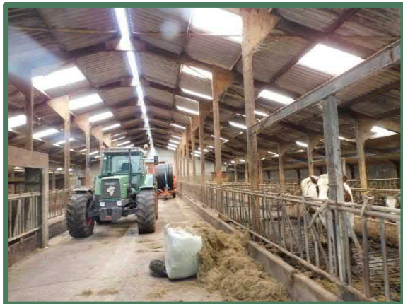
Overzicht binnenzijde te renoveren stal
