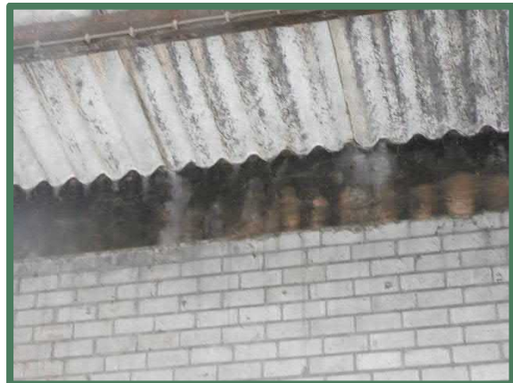
Overzicht aansluitende muurplaat
