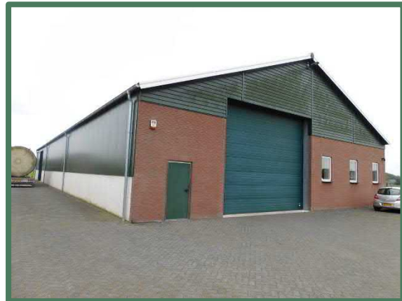
Overzicht te behouden loods
