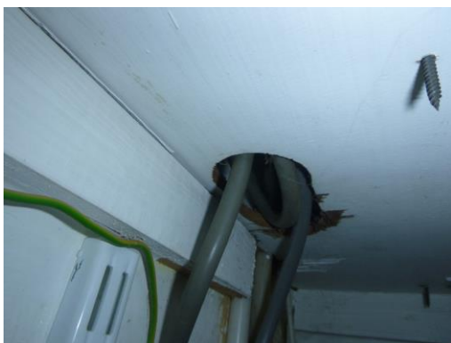
Plafond van hout in de meterkast
