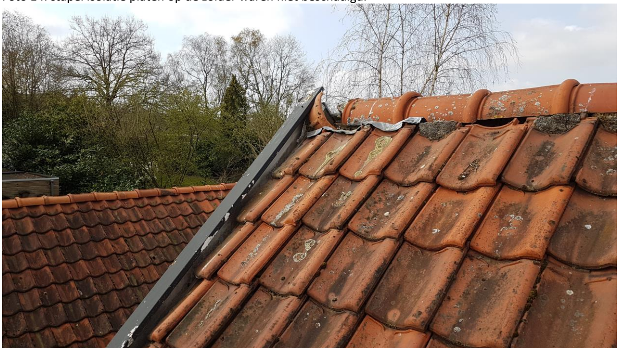
Foto 15: kapotte nokvorst waar het is in geregend. Hier zit het boeiboord deels los.
