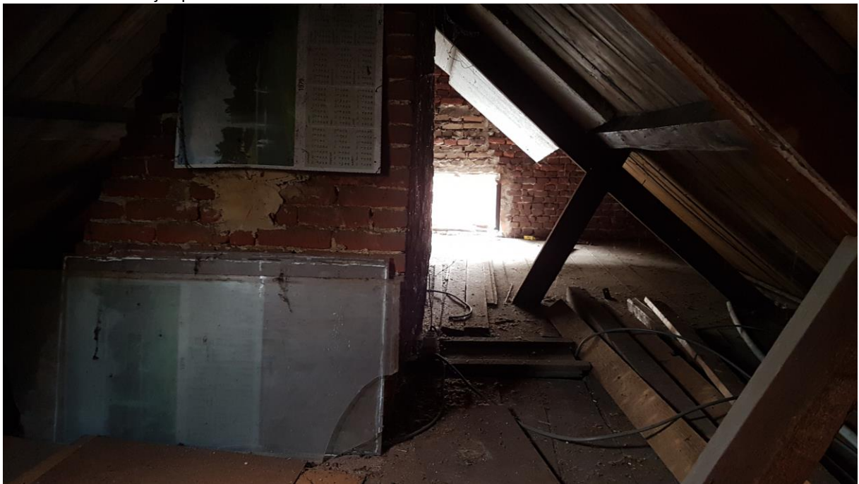
Foto 13: de zolder van het westelijke pand.
