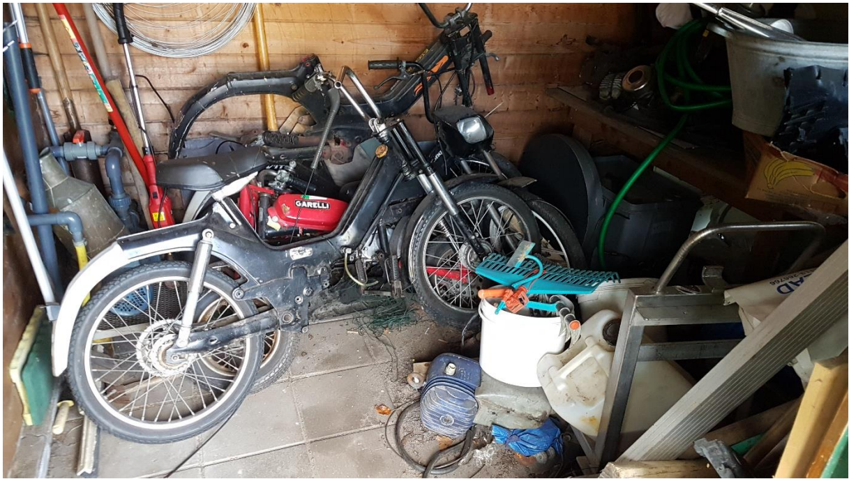
Foto 3: binnen in het te slopen schuurtje.
