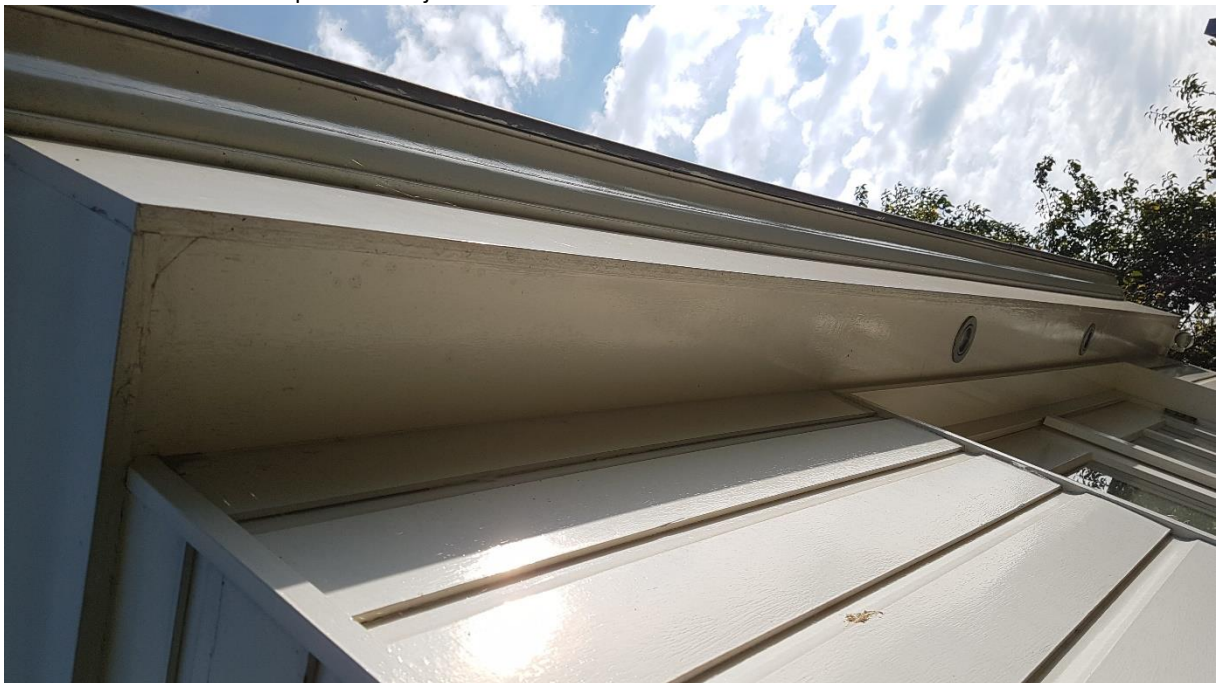
Foto 4: de zuidgevel van de te behouden schuur bevat geen gaten of spleten waarin vleermuizen, huismussen of gierzwaluwen kunnen verblijven. De bouw van de patiowoning zal dus geen aanvliegroutes blokkeren.
