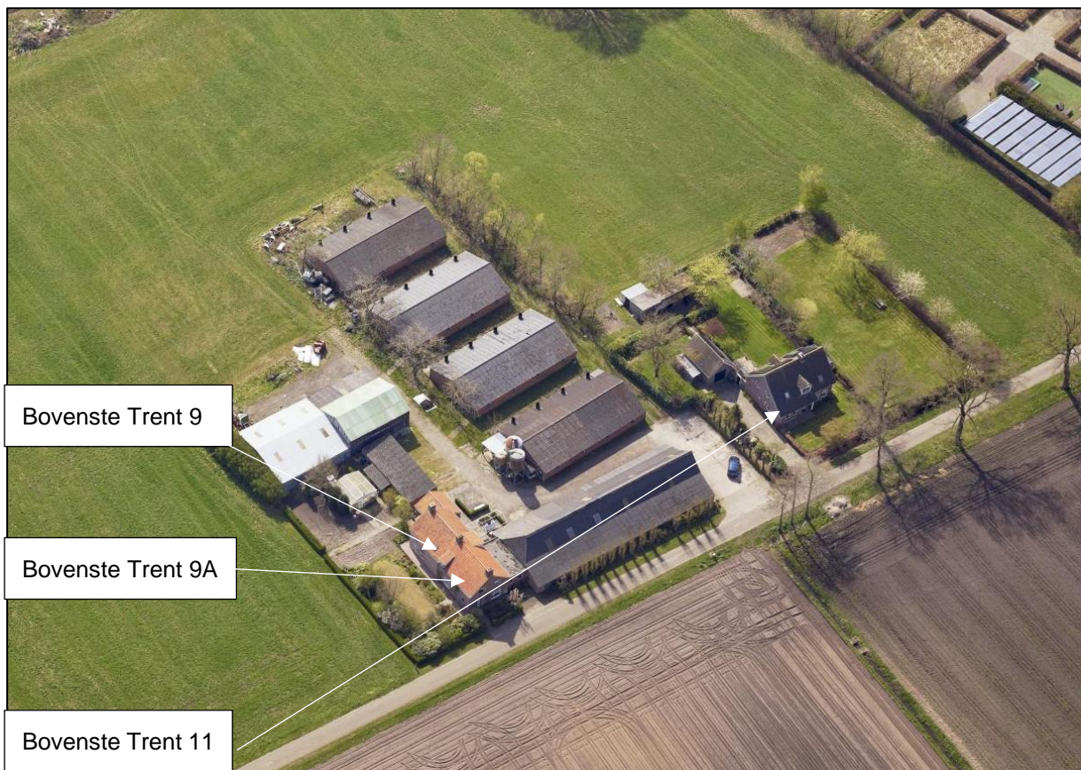
Figuur 5: Luchtfoto plangebied (Bron: Slagboom en Peeters)
