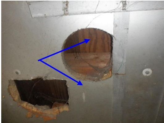
Foto 7 | Dupanel platen en houten dak
