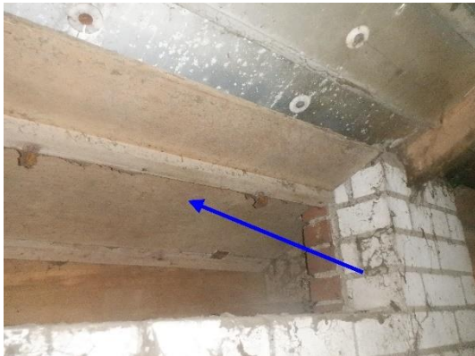
Foto 9 | Beluchtungskleppen van hout
