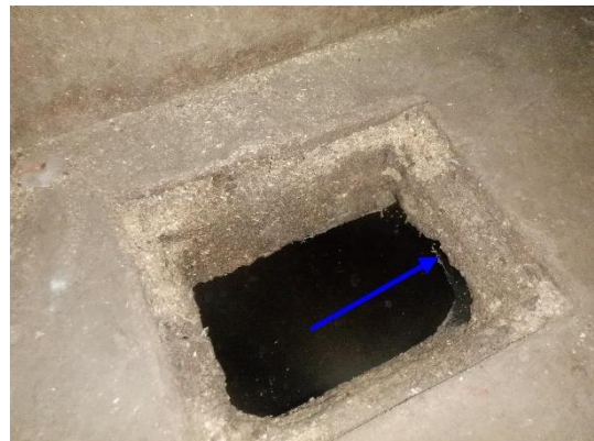
Foto 12 | Betonvloeren met betonelementen op mestputten
