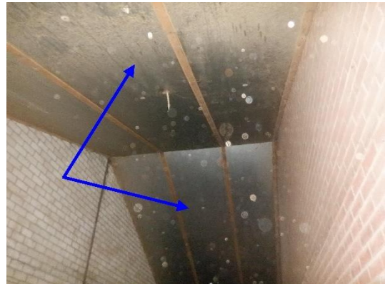
Foto 10 | Dupanel platen tegen de dakschuinte
