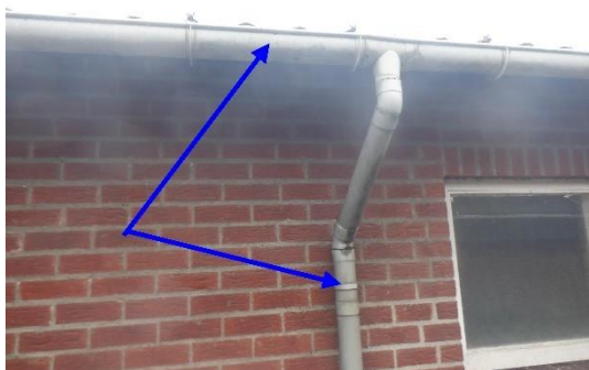
Foto 21 | Pvc hemelwaterafvoeren
