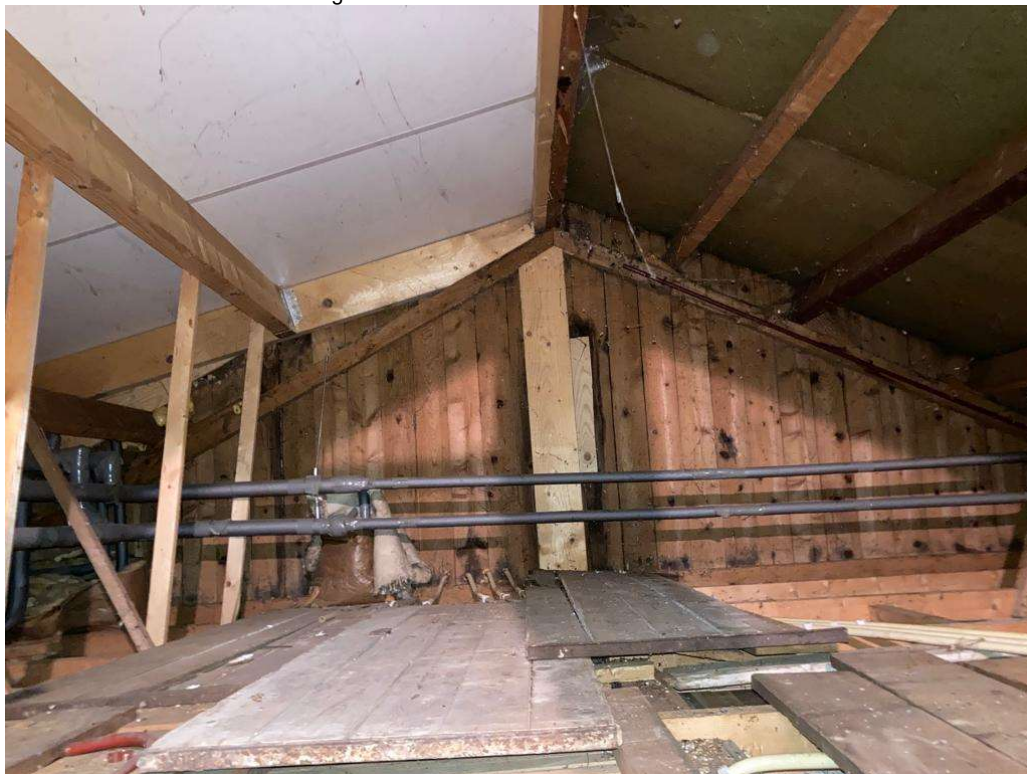
• Afbeelding 12: zolder woonhuis
