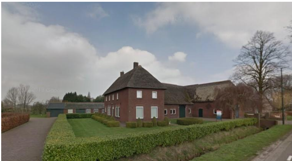
Bestaande woonboerderij met uiterst links de toerit naar het achtererf. Op de achtergrond in het midden van de woonboerderij de poort met toegang tot het achtererf.
