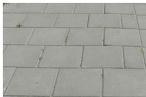
Betonklinkers op het trottoir
