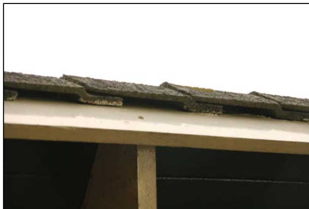
De pannenconstructie van het woonhuis biedt geschikte spleten voor (tijdelijk) verblijf van vleermuizen
