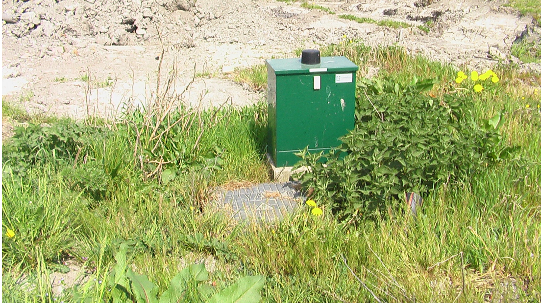
Foto 4: Aansluiting op drukriool
