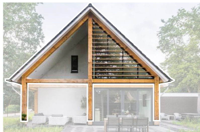
Dwarskap en houten elementen in de gevel.
