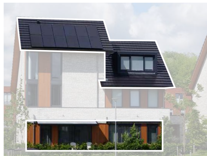
Dak met parallelle nokrichting en verhoogde nok, peilkozijnen.
