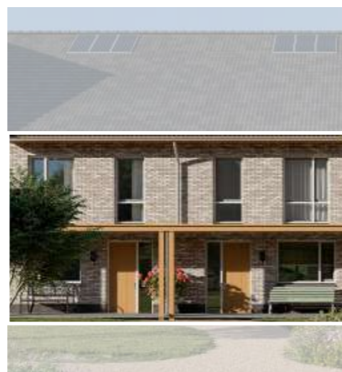
Veranda, verticaliteit door middel van regenpijpen en hoge ramen.
