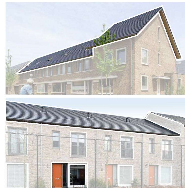
Dak met parallelle nokrichting en verhoogde nok, peilkozijnen.
