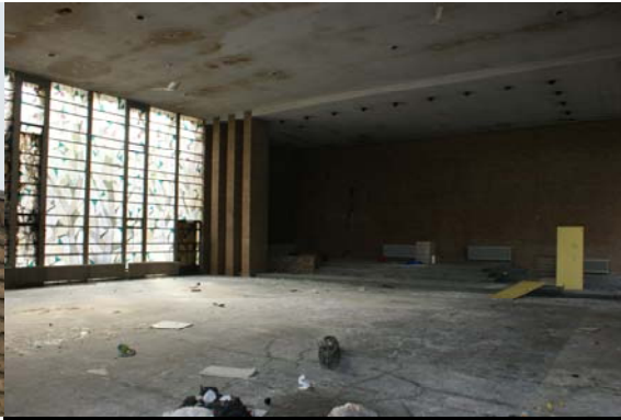
Overzicht in grote kerkzaal
