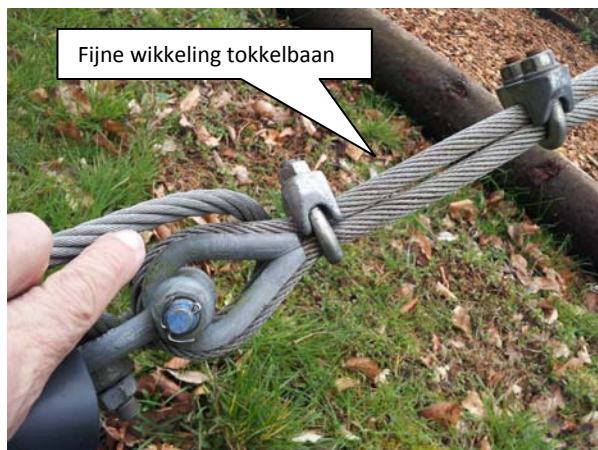
Afbeelding 6.4: geleider tokkelbaan met fijne wikkeling
