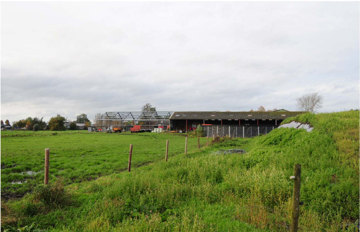
Afbeelding 11. Zicht op de wagenloods en de in aanbouw zijnde schuur naburig erf vanaf kuilvoerplaten Op de voorgrond van de wagenloods de lagere, te behouden mestsilo zichtbaar
