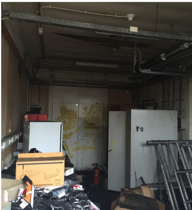
Afbeelding 38: Deel interieur kantoorgebouw 1974/9
