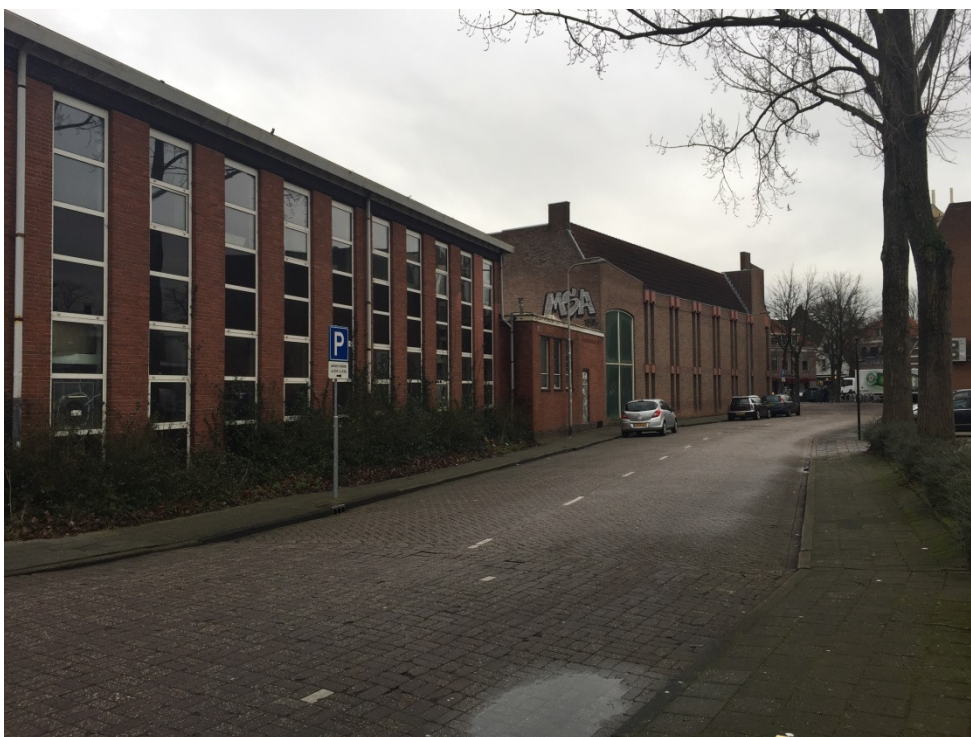
Afbeelding 41: Gebouwen 1961/5 links en 1983/72 rechts langs de Kromme Elleboog, met zicht naar noorden
