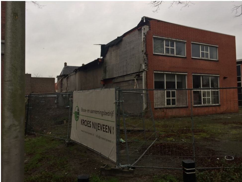
Afbeelding 35: Gebouw 1957 deels gesloopt, met aan de achterzijde de bedrijfshal en aan de voorzijde het kantoor 1974
