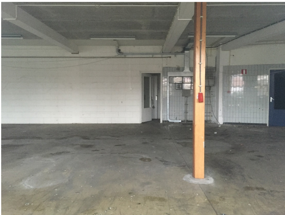
Afbeelding 42: Interieur hal 1961/5 met de funderingsplaat en de extra steunberen in de hal
