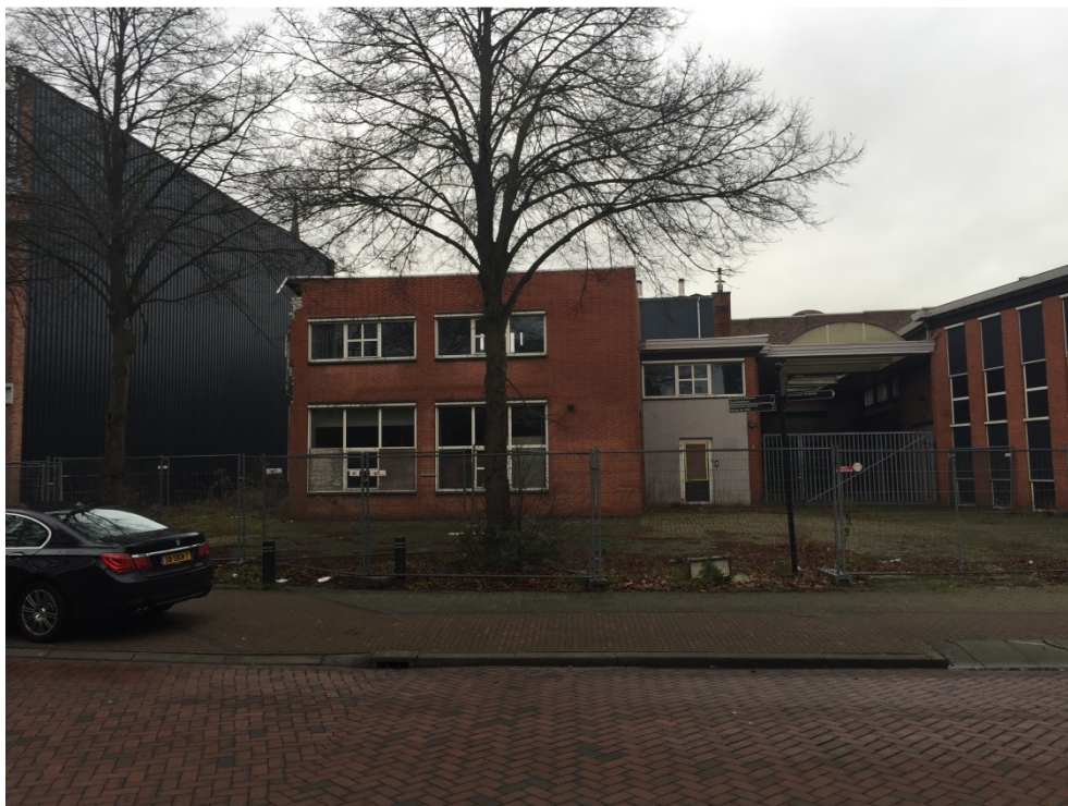
Afbeelding 36: Gebouw 1957 deels gesloopt, met aan de achterzijde de bedrijfshal en aan de voorzijde het kantoor 1974/9
