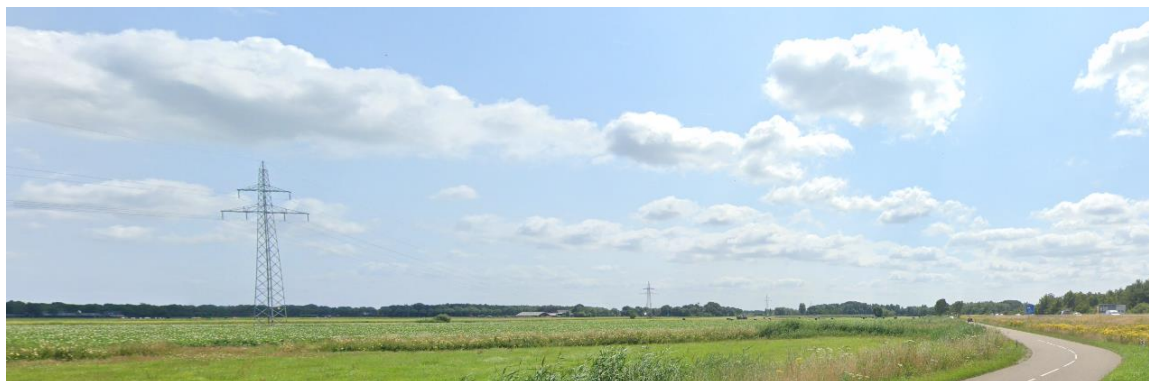
Afbeelding 3.8 Mast 19 op de voorgrond en mast 18 en 17 op de achtergrond
