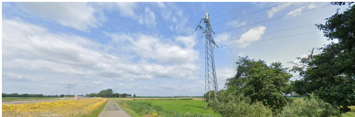
Afbeelding 3.9 Mast 20 op de voorgrond en mast 21, 22 en 23 op de achtergrond
