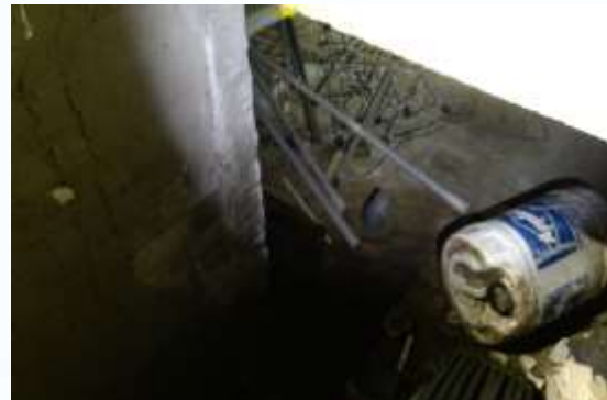
34 | Inspectie in de kruipruimte
