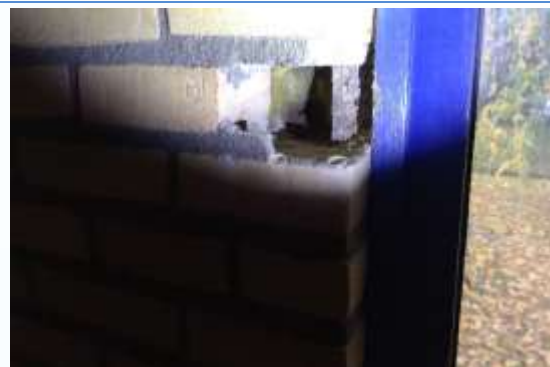
24 | Inspectie in de spouw
