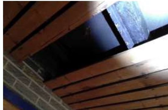
32 | Inspectie boven plafonds
