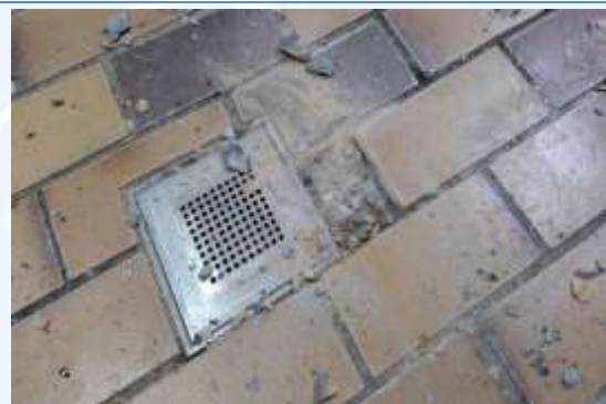
27 | Destructief handelen in vloer
