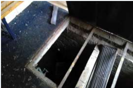
33 | Toegang tot kruipruimte
