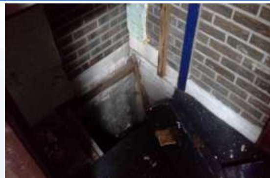
36 | Inspectie onder betonvloeren
