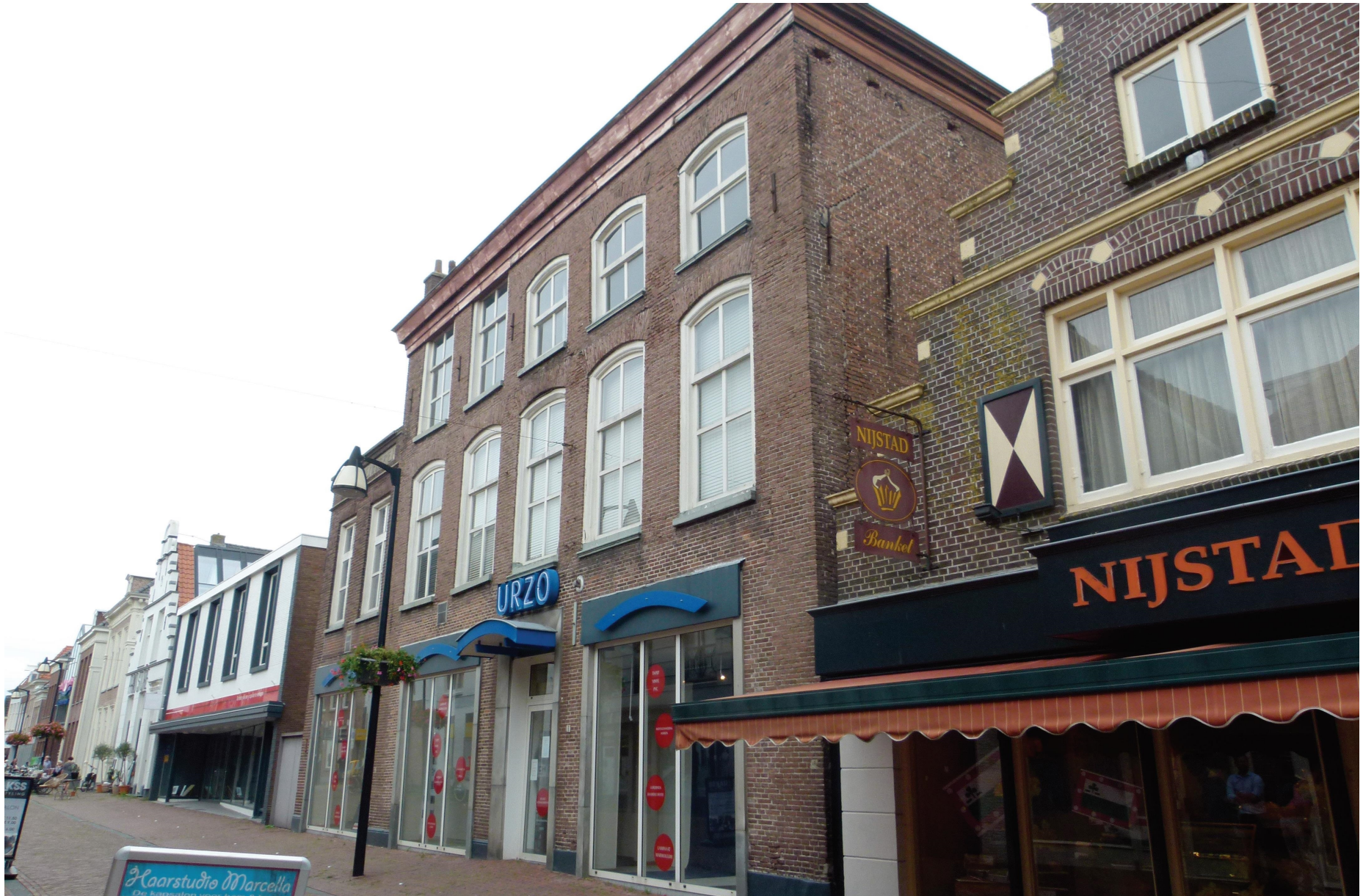
Afb. 1 Het grote pand met de vrijwel vierkante voorgevel en hete lagere pand links maken deel uit van het complex van URZO. De aanbouwen op het achterterrein zijn deels toegankelijk middels een steeg, links van het lagere volume. Toestand 2017.
