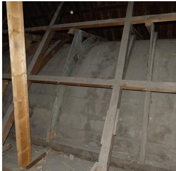
Afb. 47 Buitenzijde houten tongewelf van de toneelzaal in de kap van het linker deel van het voormalige woonhuis.
