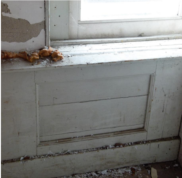
Afb. 43 Lambrijsing van de hoge ramen voorgevel op de verdieping van het rechter deel van het voormalige woonhuis.
