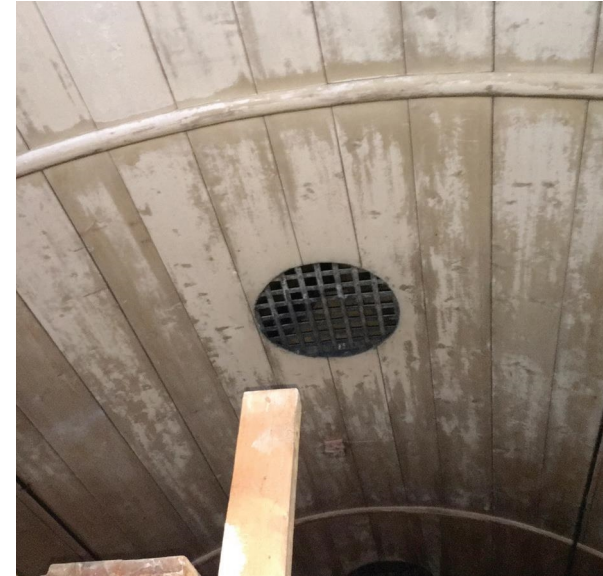
Afb. 54 In het plafond zijn gietijzeren luchtroosters aangebracht.
