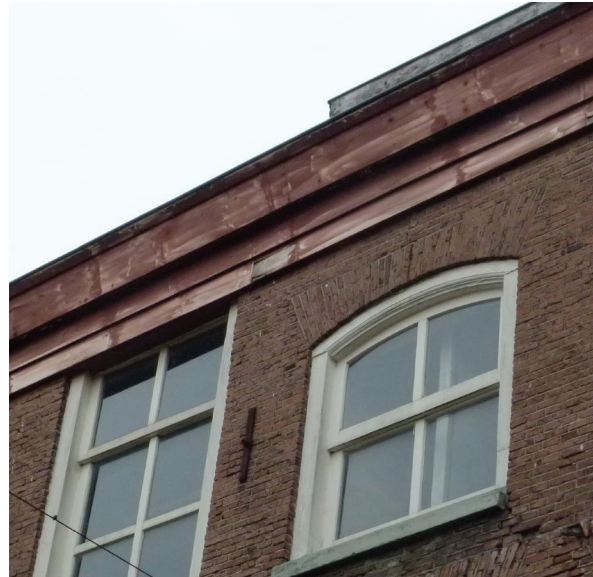
Afb. 32 De latere dakrand gaat voor de hogere ramen van de toneelzaal. Achter het kleine raam is de gangmuur zichtbaar.
