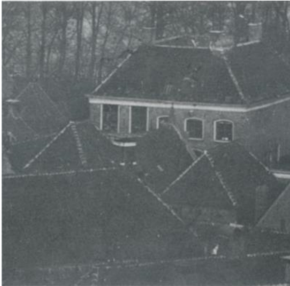
Afb. 18 De sociëteit links ramen tot de dakrand, en de zakgoot midden in het rondlopende schilddak (Wicher 1989).
