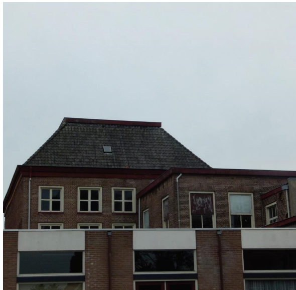
Afb. 35 Aanzicht achtergevel voormalig woonhuis met allerlei latere aanbouwen.
