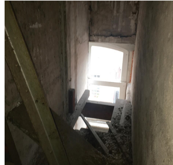
Afb. 53 In blik achter de deur op de smalle extra gang die halverwege aansluit op de ramen van de voorgevel.
