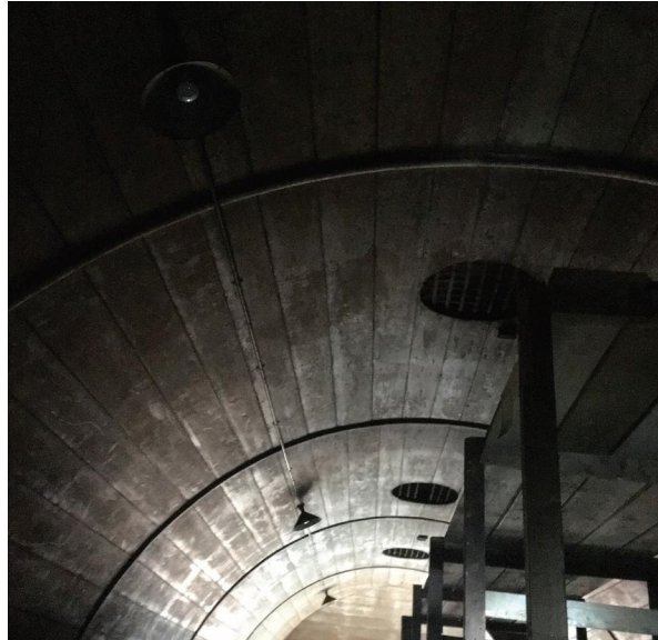
Afb. 50 De binnenzijde van het houten tongewelf van de toneelzaal.
