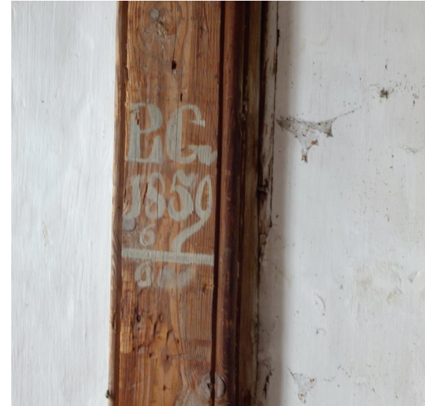
Afb. 45 De tussenmuur op de verdieping dateert mogelijk van (voor) 1859, maar sluit midden op de ramen aan.
