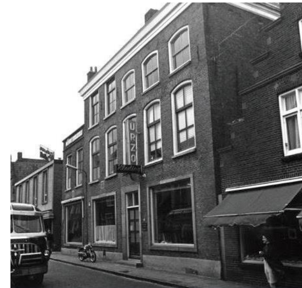
Afb. 23 Kruisstraat 6 in 1969 (Drents Archief 556).
