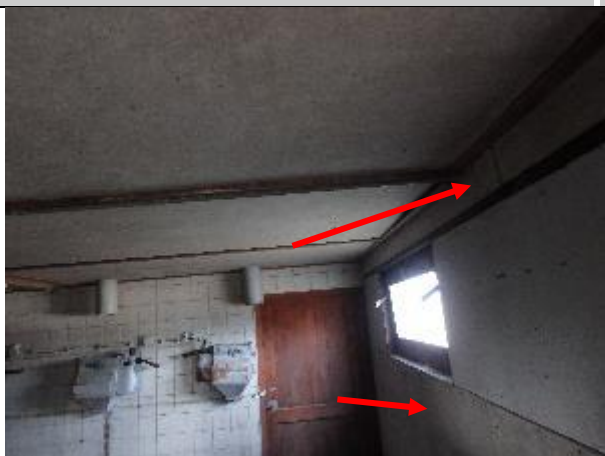
Foto nr. 11, Plaatmateriaal als wandbeplating schuur 2, M2, asbest
