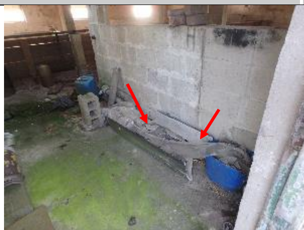
Foto nr. 13, Restanten van windveren in schuur 1, M3, asbest
