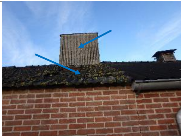
Foto nr. 25, Kunststof golfplaat en keramische dakpannen op schuur 1, niet asbestverdacht
