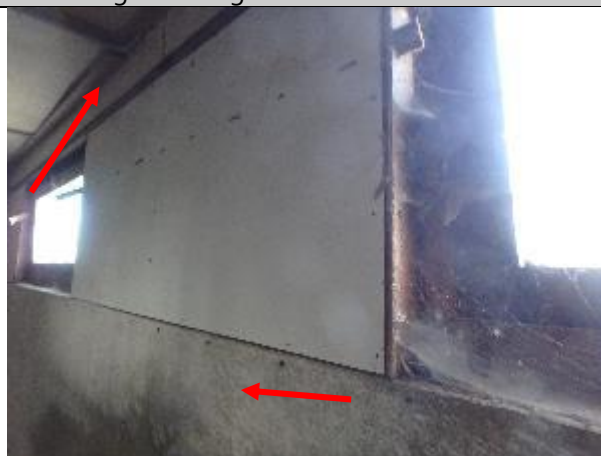
Foto nr. 12, Plaatmateriaal als wandbeplating schuur 2, M2, asbest
