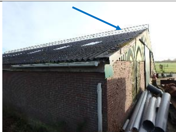
Foto nr. 26, Kunststof daklicht op schuur 2, niet asbestverdacht
