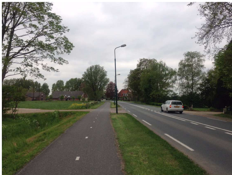
Figuur B1.1: Huidige inrit bedrijfsopstallen (bezien vanuit oostelijke richting)
