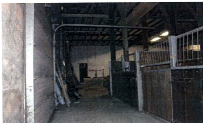
foto 23 interieur rechter zijtravee.
