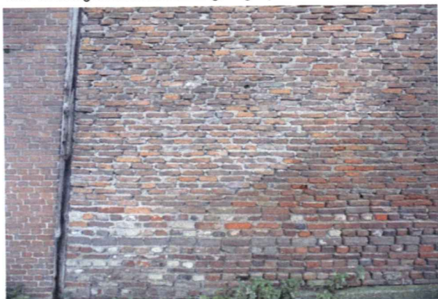
foto 15 oostgevel metselwerk middentravee.
