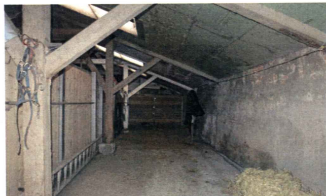
foto 24 interieur rechter zijtravee, binnenzijde zuidgevel.
