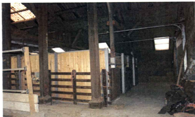
foto 20 interieur rechter zijtravee.
