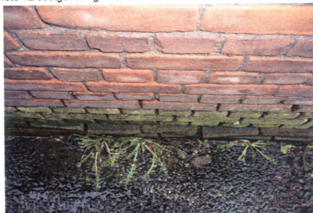
foto 14 noordgevel, rijnstenen komen uit gevel zetten.
