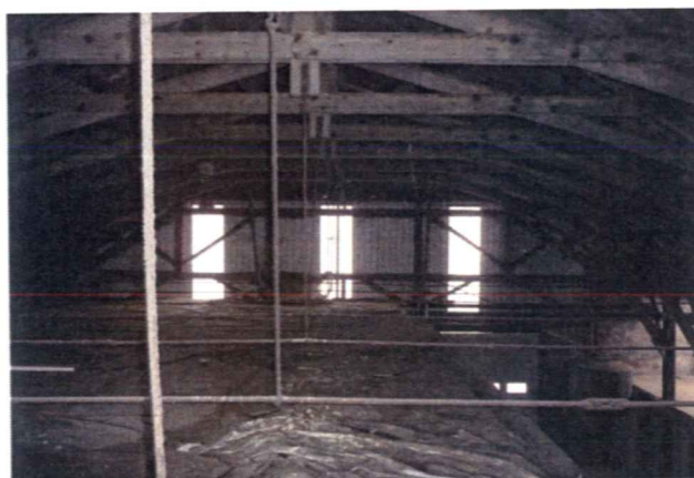
foto 30 interieur kapconstructie middenravee.
