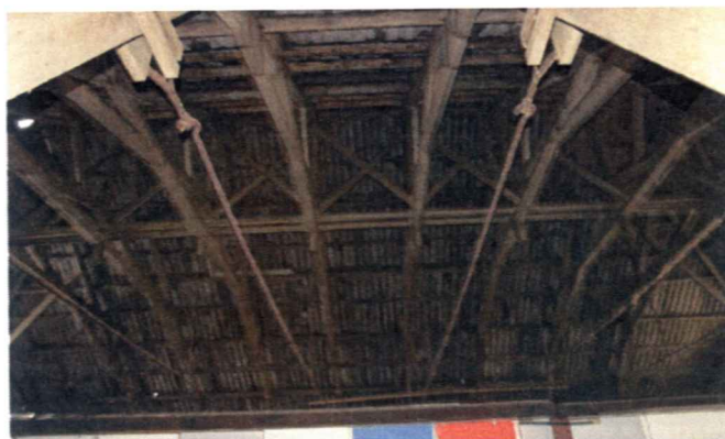
foto 28 interieur kapconstructie middenravee.
