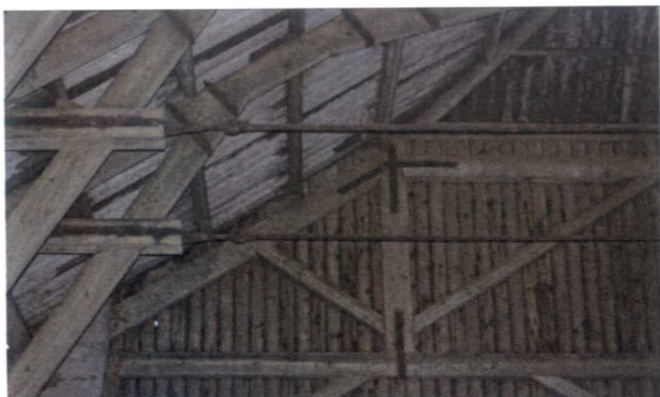
foto 25 interieur kapconstructie middenravee, oostgevel.
