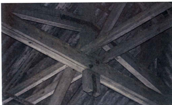
foto 27 interieur kapconstructie middenravee.
