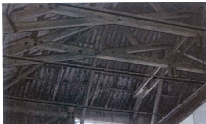
foto 26 interieur kapconstructie middenravee.
