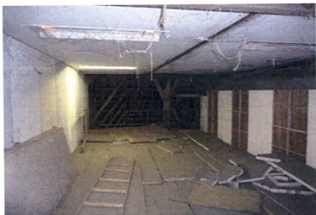
foto 29 interieur tussenlaag middenravee tpv oostgevel.
