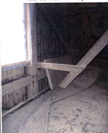
foto 32 interieur tpv oostgevel afgezaagde spantpoten.
