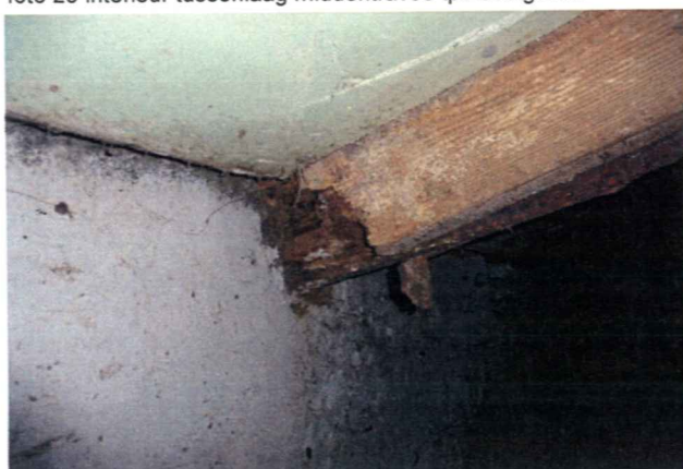
foto 31 interieur linker zijravee, ingerotte spantligger.
