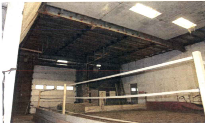
foto 21 interieur middentravee zicht naar westgevel.
