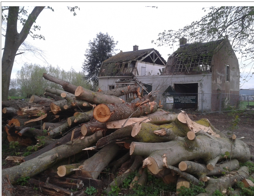
Figuur 18: Vervallen woonhuis op het erf.
