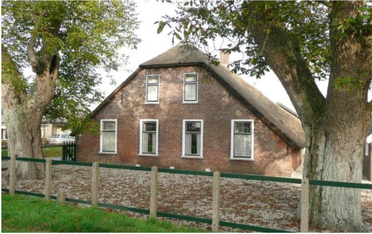
Foto van situatie najaar 2014, woning verschuift naar rechts (rechter boom is in zomer 2015 omgewaaid)
