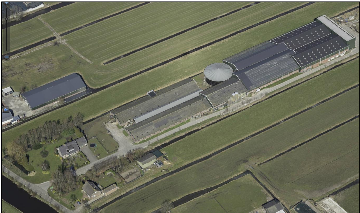
Figuur 3: luchtfoto bebouwing (voor de brand)
