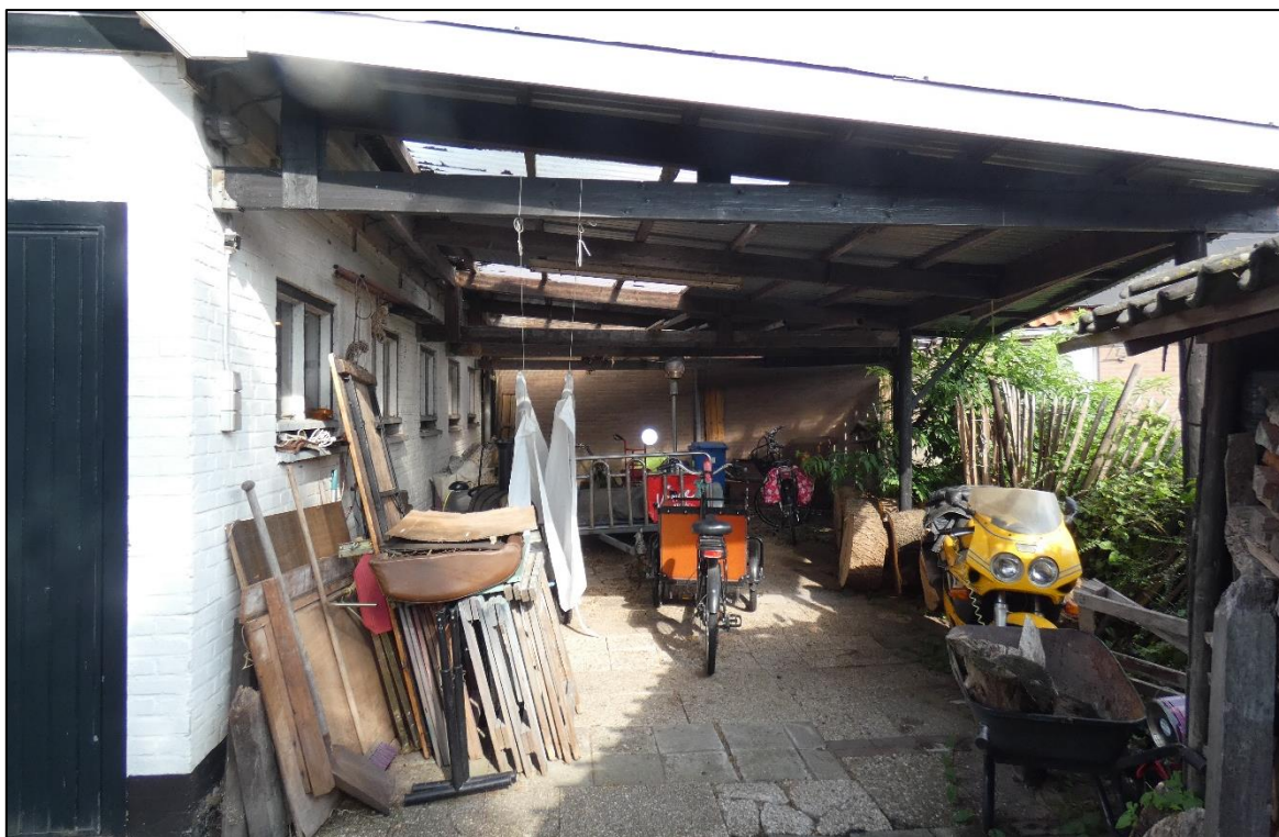
Figuur 2 De bebouwing bestaat uit één schuur opgetrokken uit bakstenen muren met een dakpannen dak en een overkapping bestaande uit houtbalken met golfplaten.
