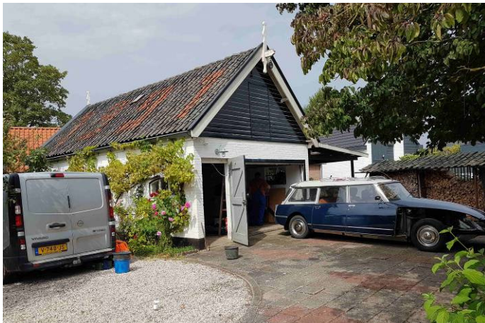
Foto 1: zuidzijde locatie (garage/berging en overkapping)
