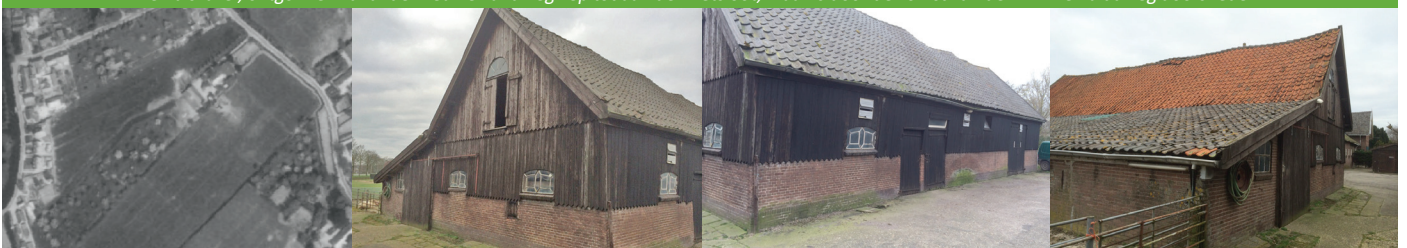
Karakteristieke schuur was in de jaren '50 (bouwjaar?) al onderdeel van het ensemble. De schuur staat haaks op de ontginningsrichting, parallel aan het voorhuis. Bron: Arco Architecten.
