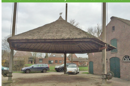
De deel van de boerderij. Bron: Arco Architecten.
