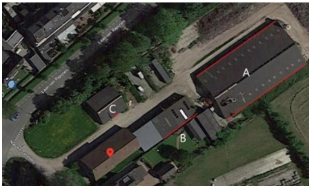
Figuur 1: Waargenomen asbesthoudende daken (A, B en C) zonder dakgoot (Bron: Satellietfoto Google)
