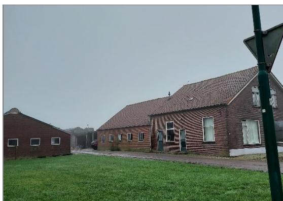
Foto 1: Woning/boerderij aan de Nieuwe Zandweg 23 bestaande uit bakstenen gevels en dakpannen.
