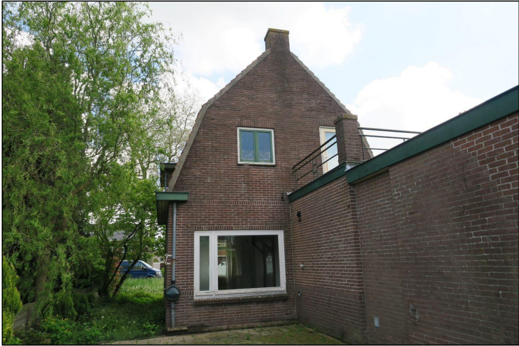
Figuur 3 De achterzijde van de woning. Deze zal gesaneerd worden.
