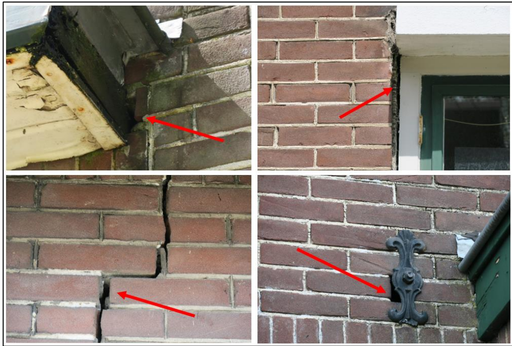
Figuur 4 Visuele representatie van openingen in de woning. Deze kunnen door vleermuizen gebruikt worden als invliegopening.
