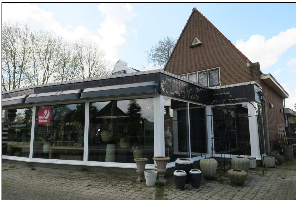
Figuur 1 Het winkelpand. Deze zal gesaneerd worden.
