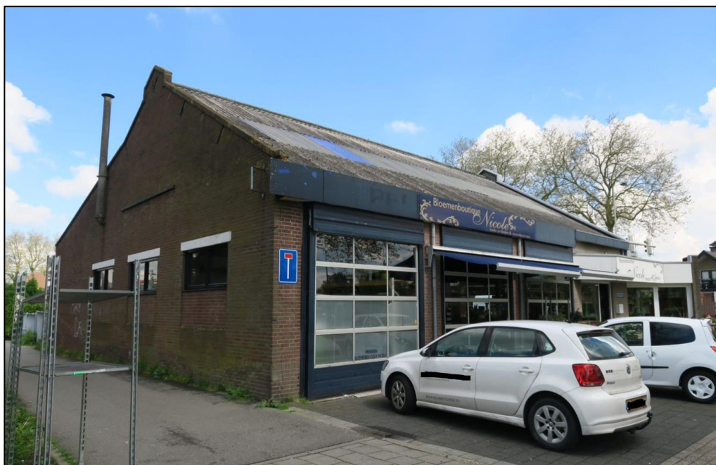
Figuur 2 Het winkelpand. Deze zal gesaneerd worden.
