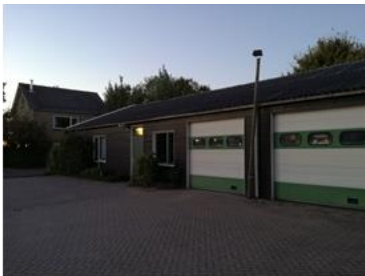
Bedrijfsruimtes met bitumen dakbedekking achter de woning.
