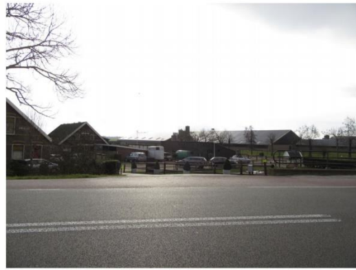
beeld voorzijde percelen Willeskop 77 en 77c, door verschillende bebouwde elementen, auto's en verschillende hekwerken oogt het enigszins rommelig.
