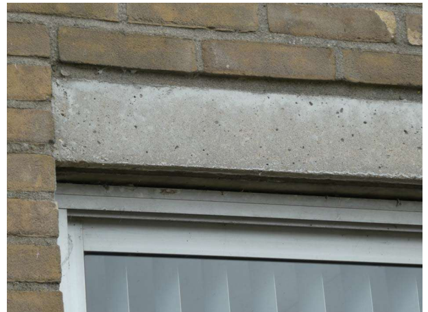
Figuur 20: Afgewerkte overgang van kozijn naar gevel; er zijn geen kieren
