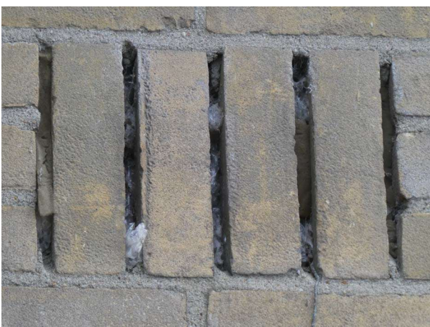
Figuur 17: Afgesloten ventilatiespleten
