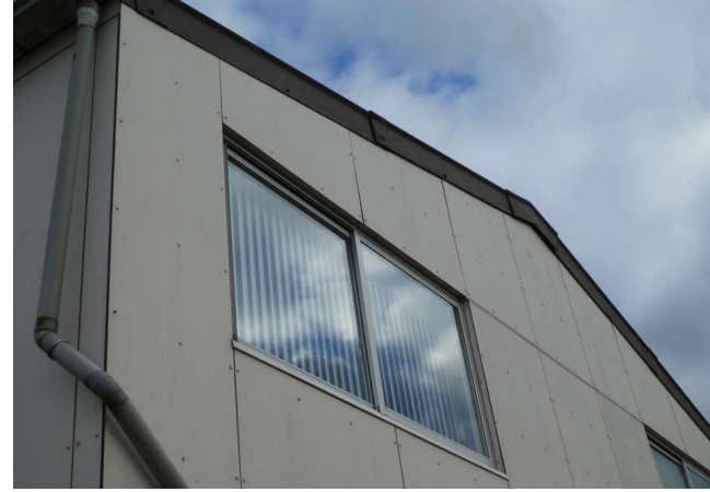
Figuur 16: Daklijst aan oostzijde gevel (l) en trespaplaten (r) aan westgevel
