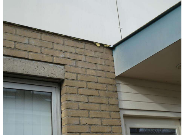
Figuur 18: Aansluiting kozijnen op gevel en afdichting trespaplaten met PUR
