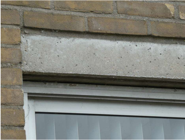
Figuur 18: Aansluiting kozijnen op gevel en afdichting trespaplaten met PUR
