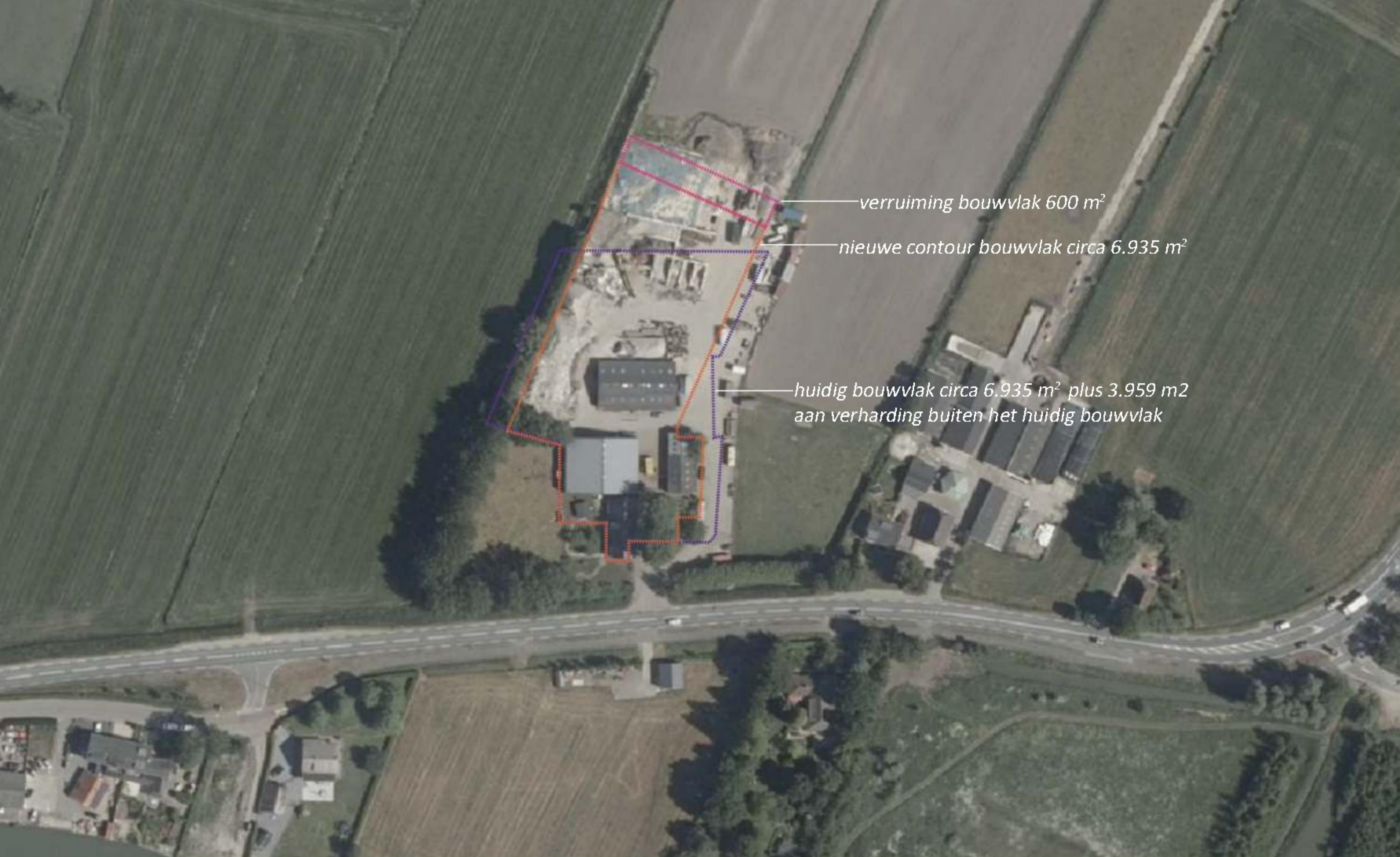
Veel bedrijfsactiviteiten en verharding buiten huidig bouwvlak
