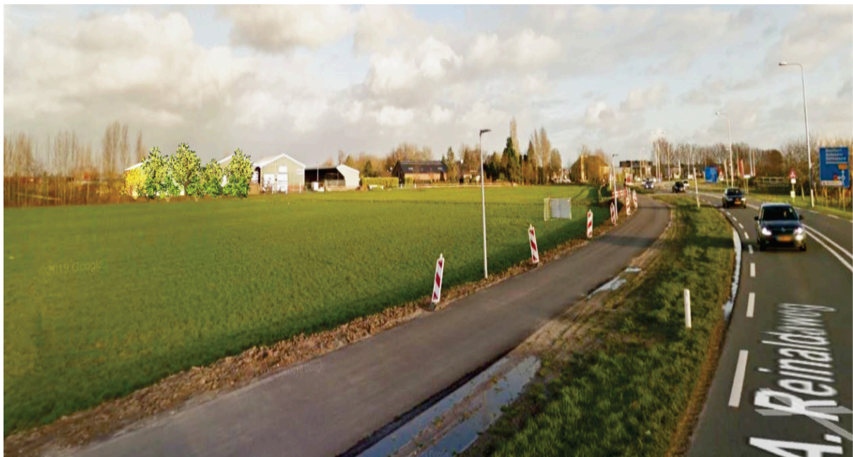
toegevoegde beplanting aan de westkant van de nieuwe bedrijfshal
