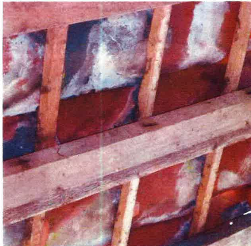
afbeelding 12. Zicht op de binnenzijde van een van de dakschilden. De panlatten zijn ten opzichte van de sporen nauwelijks verweerd. Ook hier zijn de gesmede spijkers met de grotere hart-op-hartafstand aan de zijkant herkenbaar.
