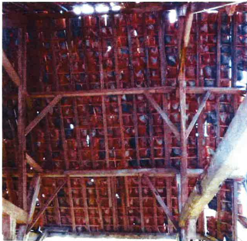
afbeelding 10. Zicht op de binnenzijde van het noordelijk dakschild. Het merendeel van de sporen is eenzijdig opgedikt met een grenen lat, welke rechthoekig van doorsnede is.
