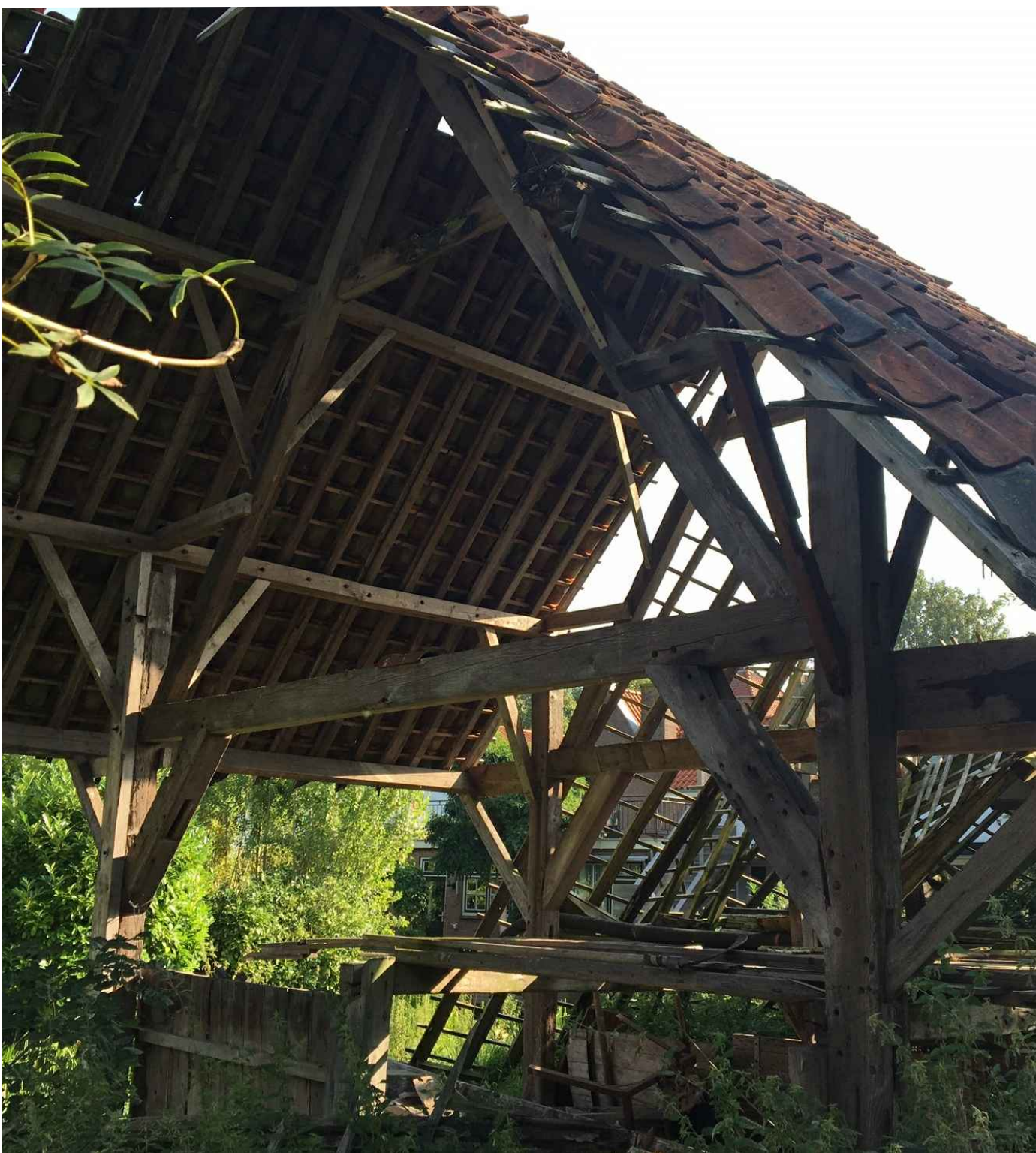
AFBEELDING SPANTEN CONSTRUCTIE
