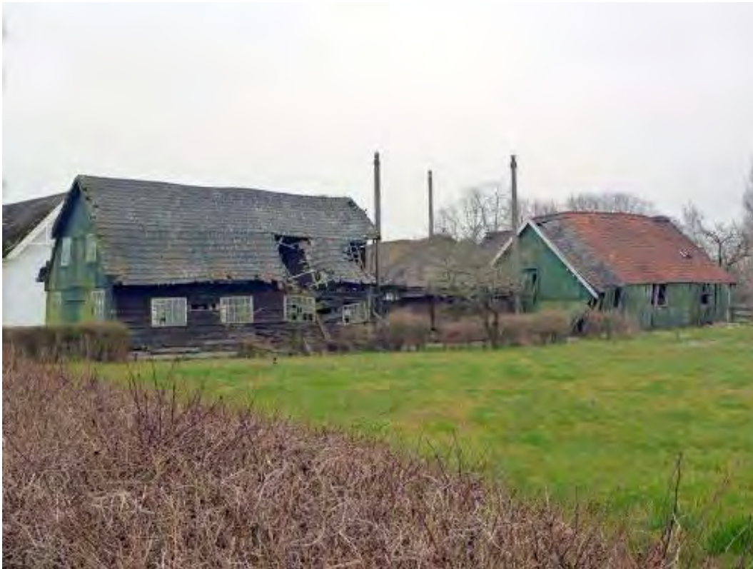
Situatie omstreeks 2016, met links de inmiddels verdwenen werkplaats en rechts de koestal.
