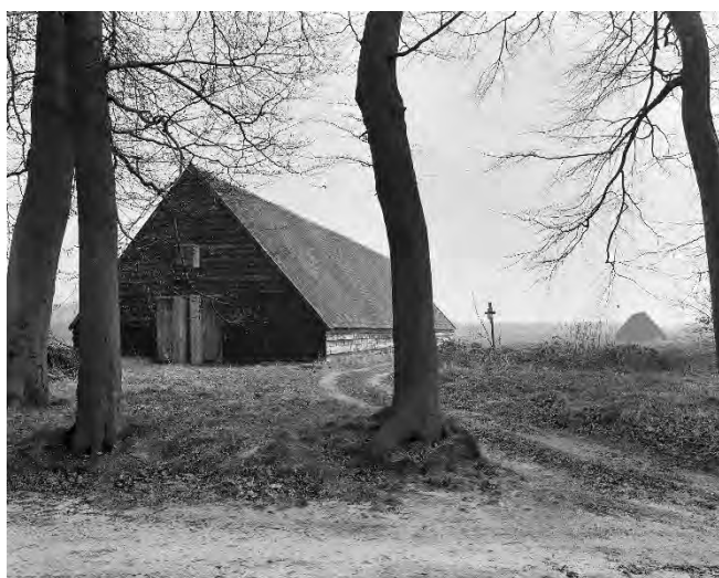
Tabaksschuur aan de Kersweg 28, Amerongen
