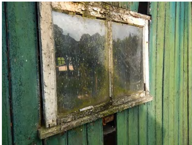
Koeienstal beglazing geen asbestverdacht materiaal
