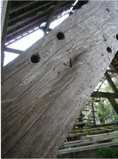
Korbeel met telmerk (V) en niet-gebruikte pen-en-gatverbindingen.
