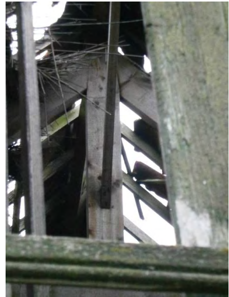
Afb.23 Deel van de kapconstructie
