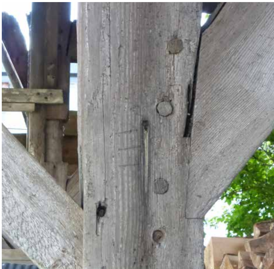
afbeelding 7. Gehakt telmerk op een van de gebintstijlen. Telmerken II, III en VI zijn groter ingekerfd.
