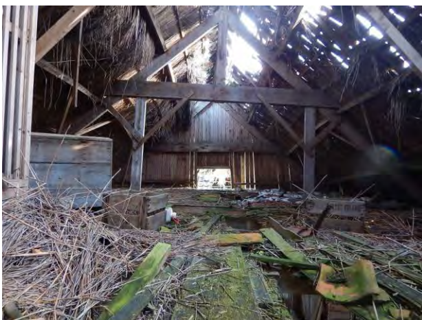
Vliering koeienstal geen asbestverdacht materiaal
