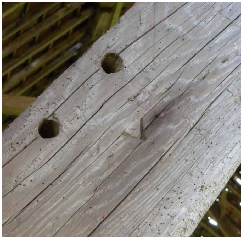
afbeelding 8. Telmerk V op een van de korbelen. Telmerken V en VII zijn kleiner ingekerfd.
