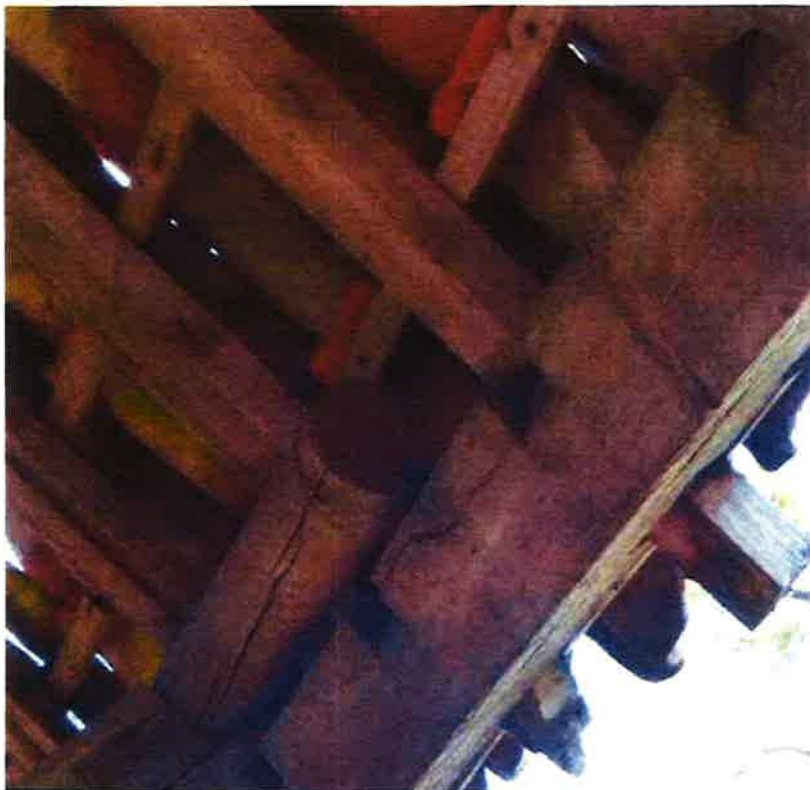
afbeelding 11. In beeld is een voormalige gebintplaat onder een hoek van 45 graden, met onbenutte inkepingen van daksporen.
