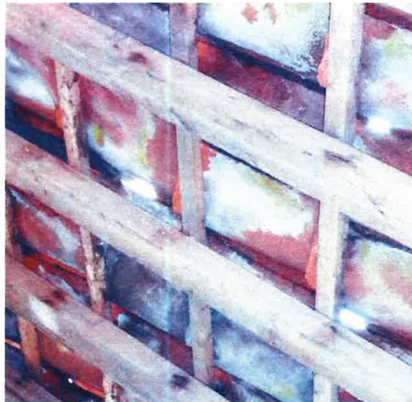
afbeelding 9. Zicht op de sporen, panlatten en holle pannen. Aan één korte zijde van elke spoor zijn smeedijzeren nagels te ontdekken. De hart-op-hart afstand van deze smeedijzeren nagels is beduidend groter dan die van de panlatten.
