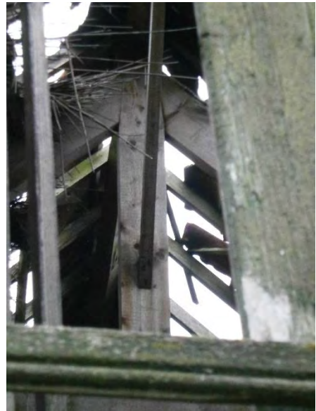
Afb.23 Deel van de kapconstructie
