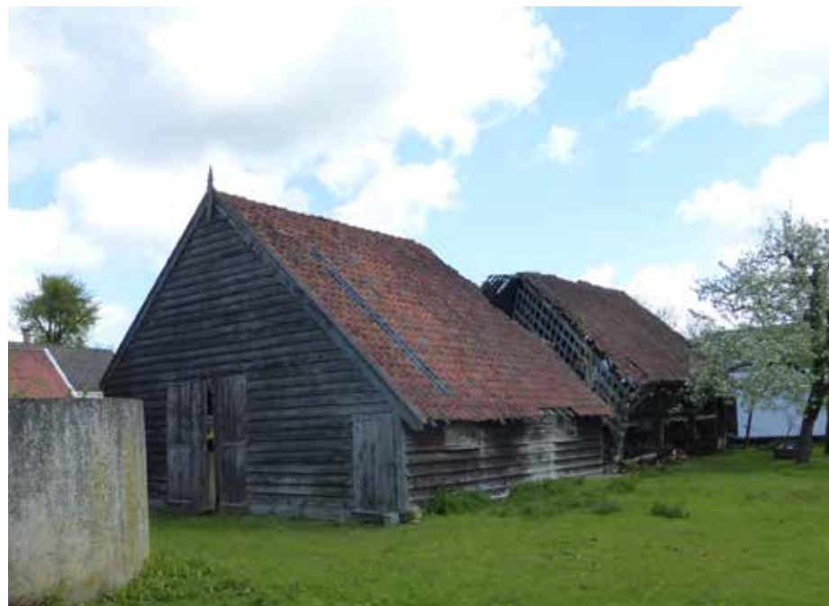
afbeelding 4. Overzichtsfoto van de rijksmonumentale schuur, gezien vanuit het zuidwesten, met links de voormalige paardenstal en rechts de droogschuur.
