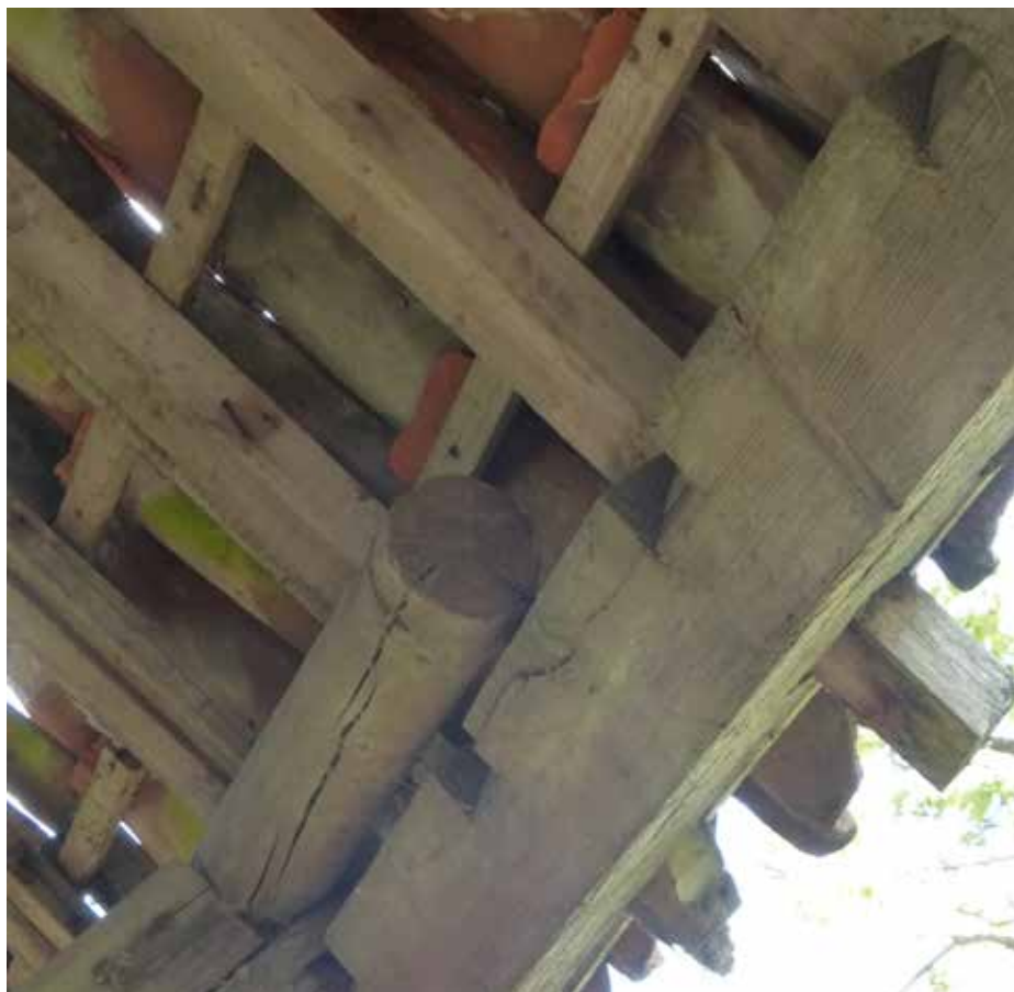
afbeelding 11. In beeld is een voormalige gebintplaat onder een hoek van 45 graden, met onbenutte inkepingen van daksporen.
