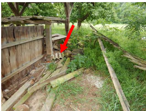
Bron 1 golfplaat overzicht
